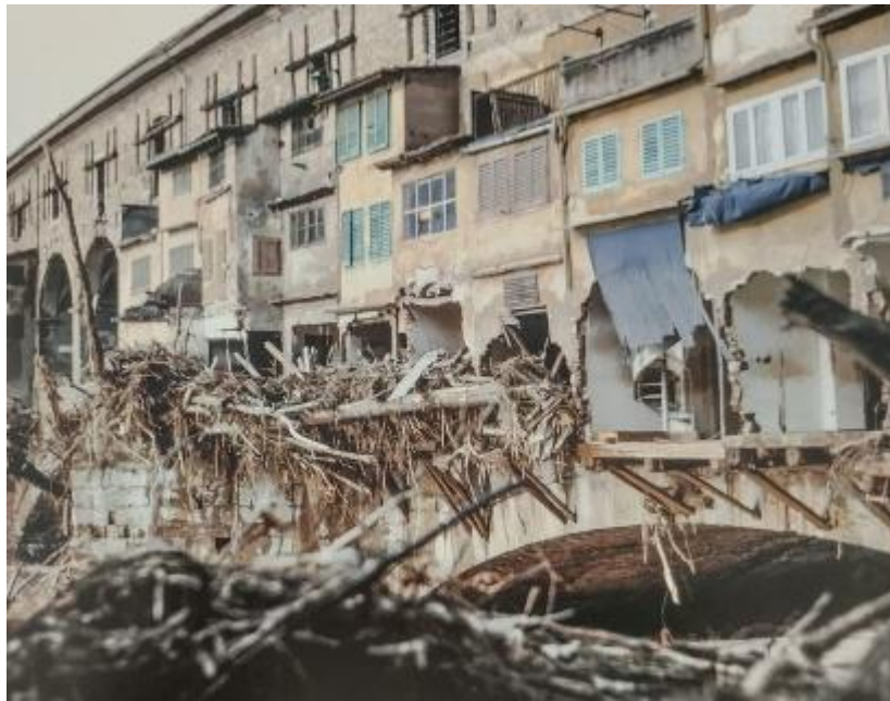
Ponte Vecchio travolto: fece da barriera a tutto ciò che la piena trascinava a valle
