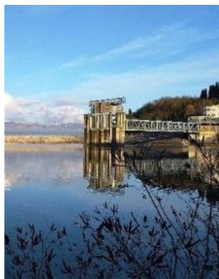
Bilancino, parte della diga che preleva l'acqua
