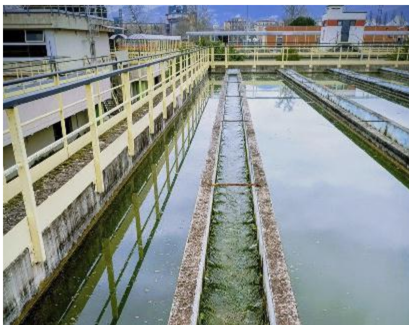
L'impianto di potabilizzazione dell'Anconella, un dettaglio delle vasche
