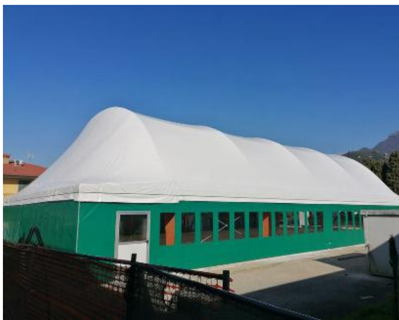
La tensostruttura realizzata all'Istituto Camaioire 3 di Capezzano Pianore
