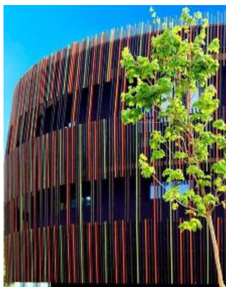
Biodigestore di Montespertoli
