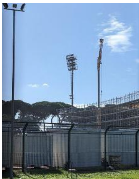
Il cantiere dello Stadio dei Pini, oggi
