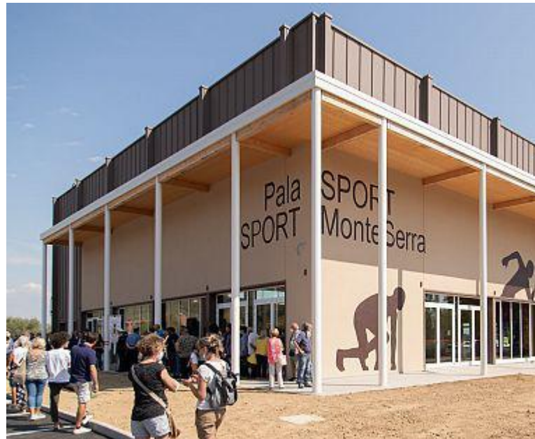
Il nuovo palazzetto dello sport «bio» di Cascine di Buti
